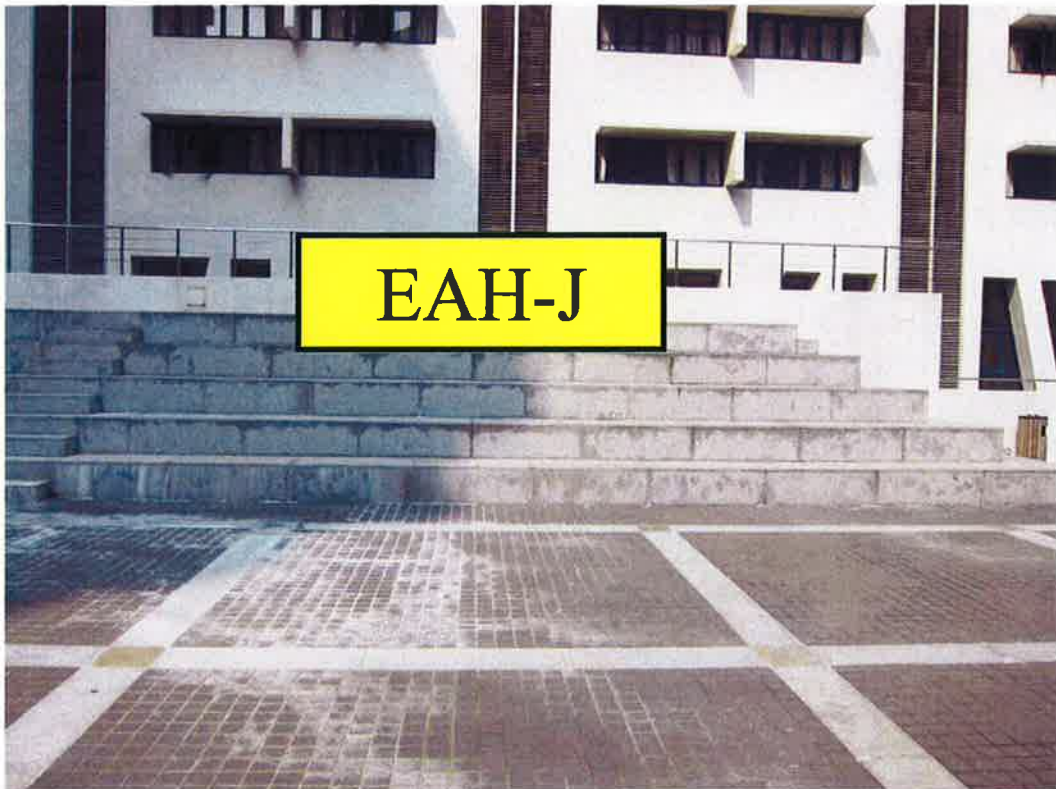
EAH G-J 東亞樓 9 樓平臺樓級處(200cm x 90cm) Railings on the EAH 9 th Floor Stairs
